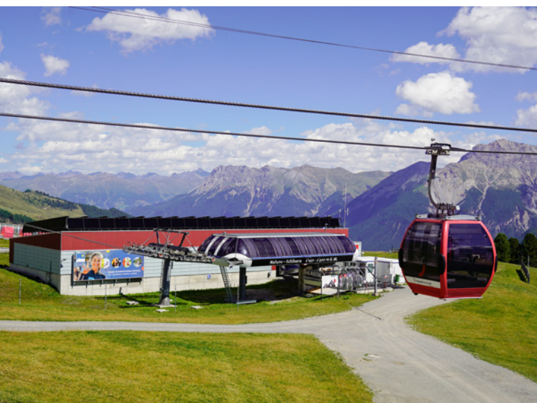
Auf der Mittelstation Motta Naluns oberhalb von Scuol haben REG.LAS und das SPF eine zweite Testanlage gebaut.
